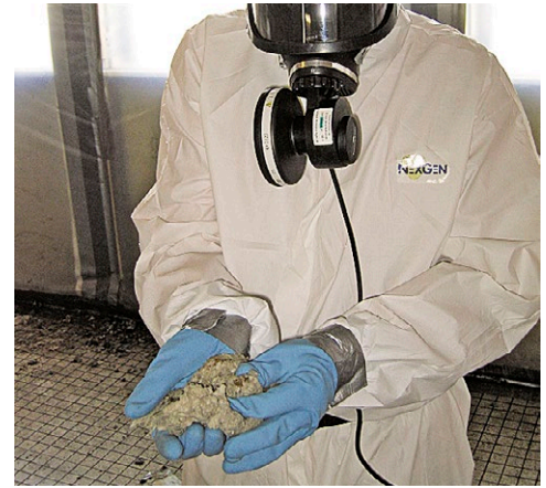
Asbest ist in höchstem Mass gesundheitsschädigend. Bild: Suva
